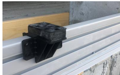
Beslaget monteres på det lodrette profil. Vinduerne opløses og understøttes helt ud under karmen.
