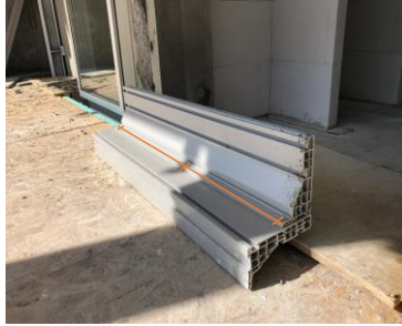
Profiler stilles oven på hinanden og skrues sammen. Placering af skruer:
